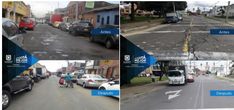
Imagen 15 y 16. Intervenciones a vías de la localidad
